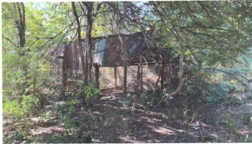
๑๙. อาคารราชพัสดุหลังลำดับที่ ๒๒ บ้านพักนักรการภารโรง จำนวน ๑ หลัง
